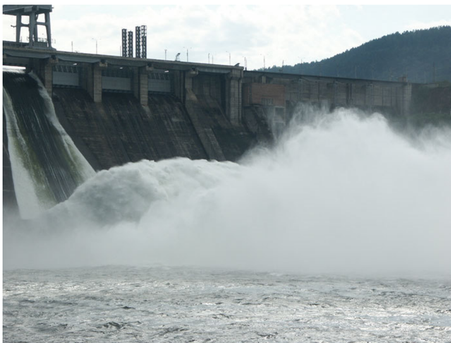
Imagen 14: Central hidroeléctrica. Fuente: https://upload.wikimedia.org/wikipedia/commons/9/9b/Krasnoyarsk_hydroelectric_station.jpg . Autor: Vadimpl. Licencia: Creative Commons (CC)
