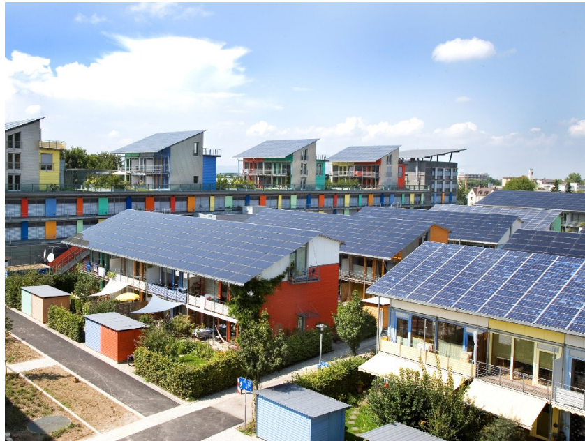
Imagen 12: Viviendas sostenibles alimentadas con energía solar fotovoltaica en Friburgo (Alemania). Autor: Andrewglaser. Fuente: Creative Commons (CC). Fuente: https://upload.wikimedia.org/wikipedia/commons/b/b8/SoSie%2BSoSchiff_Ansicht.jpg .
