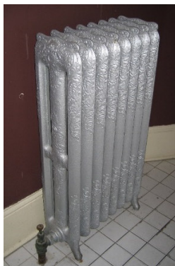
Imagen 19: Radiador fundido. Autor: Infrogmation. Licencia: Creative Commons (CC) Fuente: https://upload.wikimedia.org/wikipedia/commons/b/b1/RadiatorColumns.jpg .
