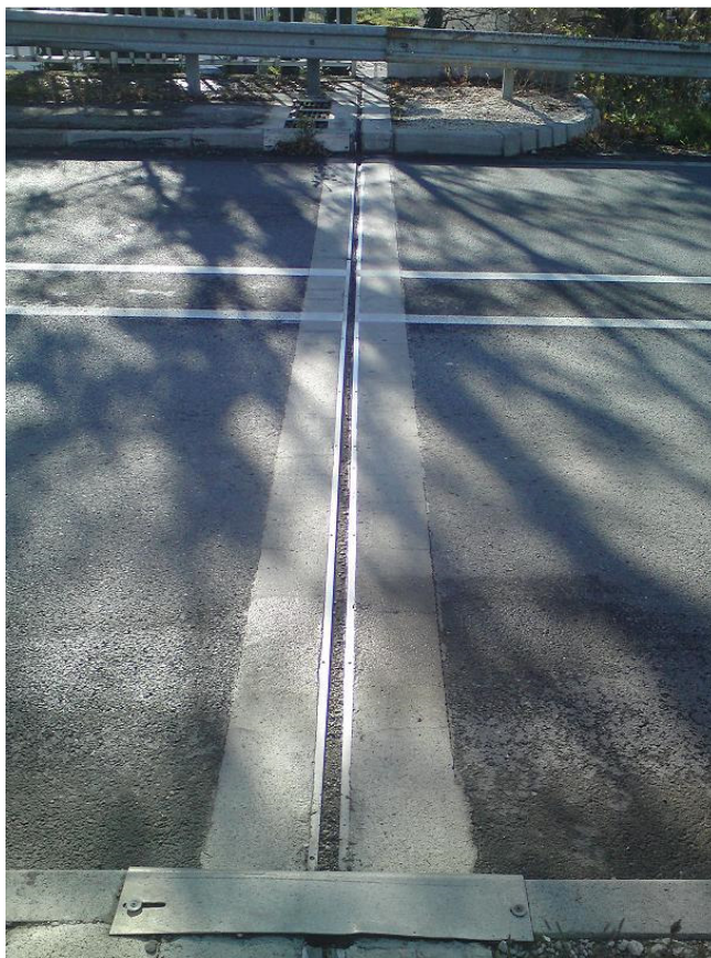
Imagen 5: Juntas de dilatación de un puente. Fuente:
